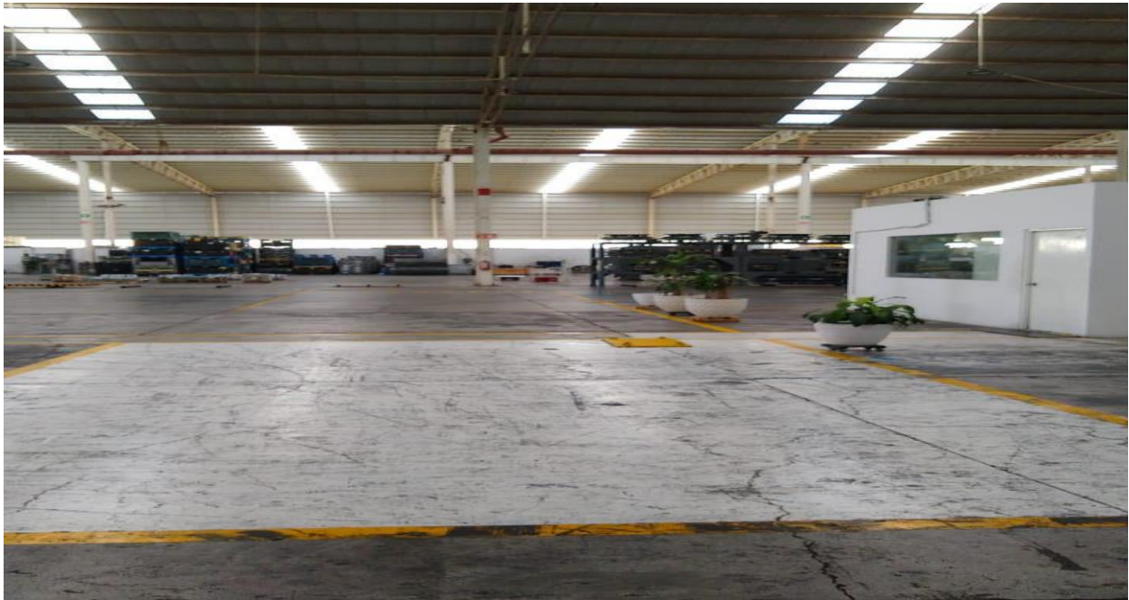
Ilustración 2. 2 Infraestructura de la empresa STAMPTEK. fuente: STAMPTEK S.A DE C.V 2024
